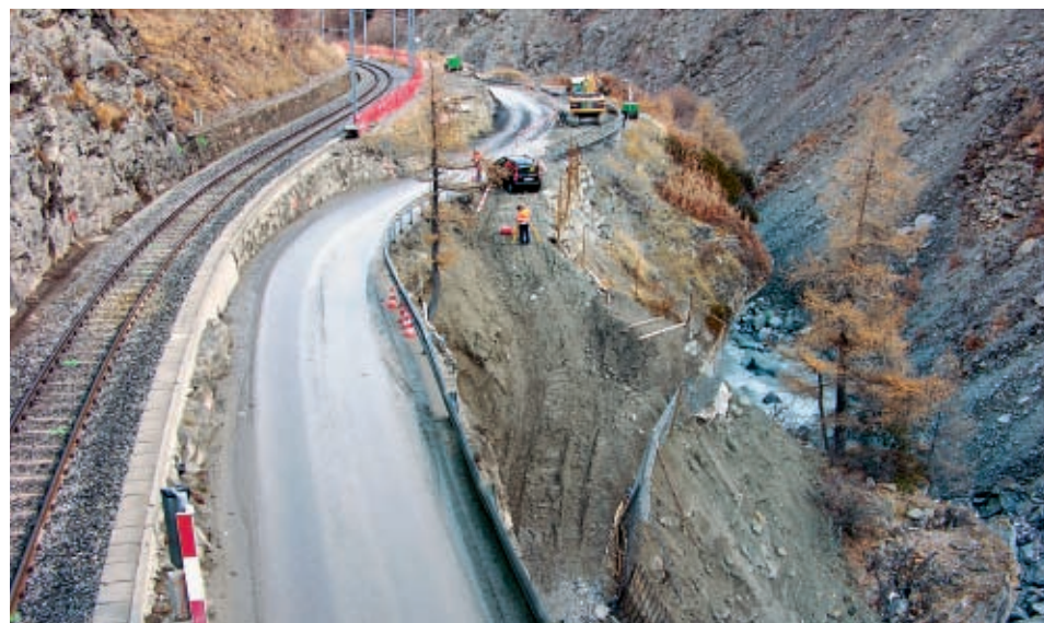
Absenkungsarbeiten im «Lüegelti».
