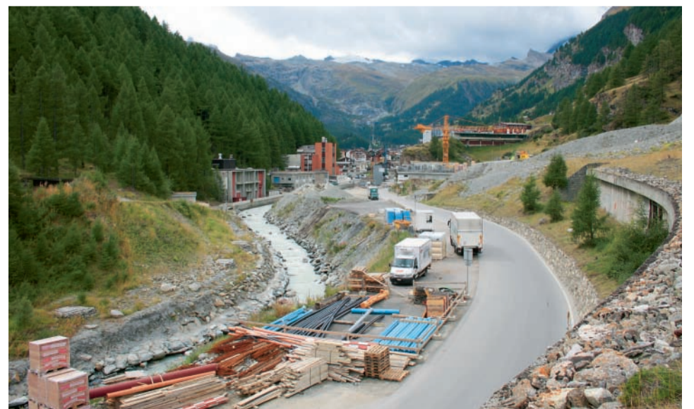
Die aktuelle Situation bietet keinen schönen Anblick: Liegen gebliebenes Baumaterial sorgt für einen ersten Eindruck von Zermatt.
