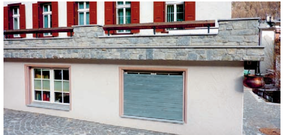
Hoffen wir, dass dieses Objektschutzsystem nur bei Übungen zum Einsatz gelangt.
