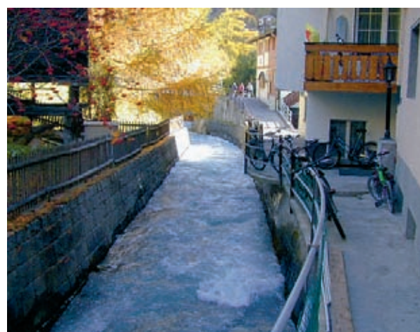
Die Erhöhung von Ufermauern sowie mobile Einrichtungen zum Überflutungsschutz sorgen für mehr Sicherheit beim Triftbach.
