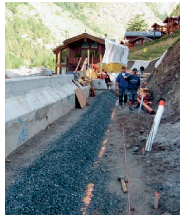
Berg- und talseitige Stützmauern wurden in der zweiten Bauetappe der Erschliessungsstrasse Zer Bännu errichtet.
