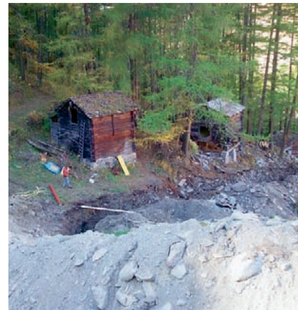
Das steile Gelände und die engen Platzverhältnisse erschweren die Arbeiten an den Werkleitungen.
