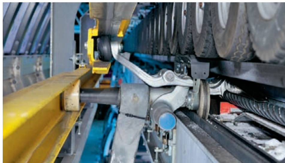
Kuppelvorgang: Die Gondel wird durch eine Klemme mit Federwinkel auf dem Förderseil festgeklemmt.
