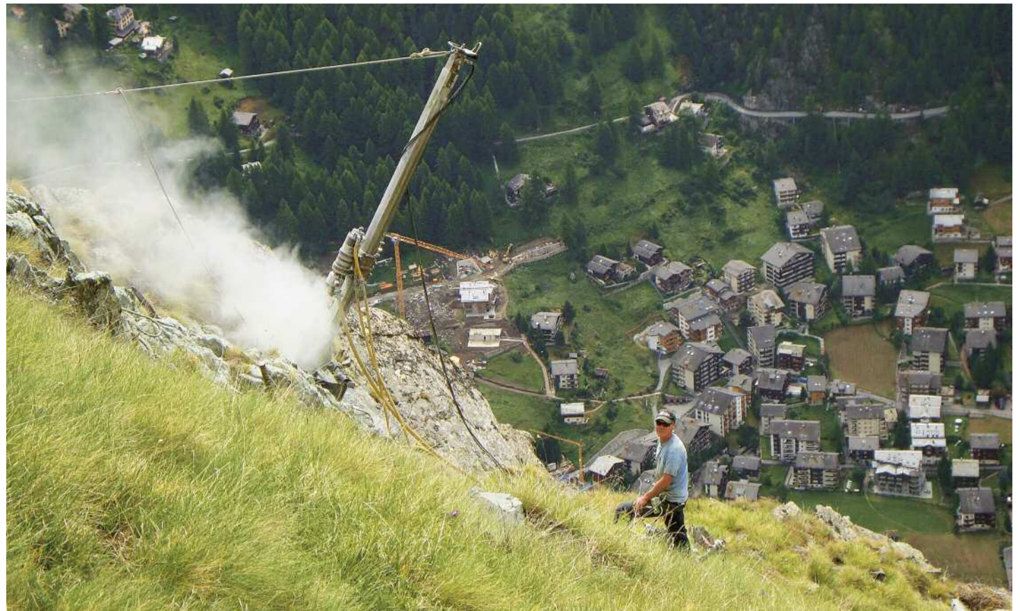
Lawinenverbauungen bringen mehr Sicherheit für das Quartier Spiss. Im Bild Bohrarbeiten für Mikropfählfundierung.
