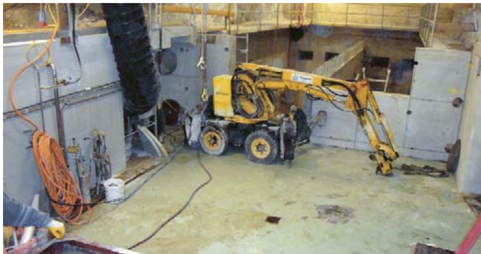
Betonabbrucharbeiten in vollem Gang.
