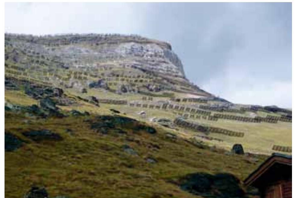
Um die Sonne zur Energiegewinnung zu nutzen, wird nun geprüft, die bestehenden Infrastrukturen der Lawinenverbauungen Schweifinen oberhalb Bahnhof Zermatt zu nutzen und mit Solarzellen auszurüsten.
