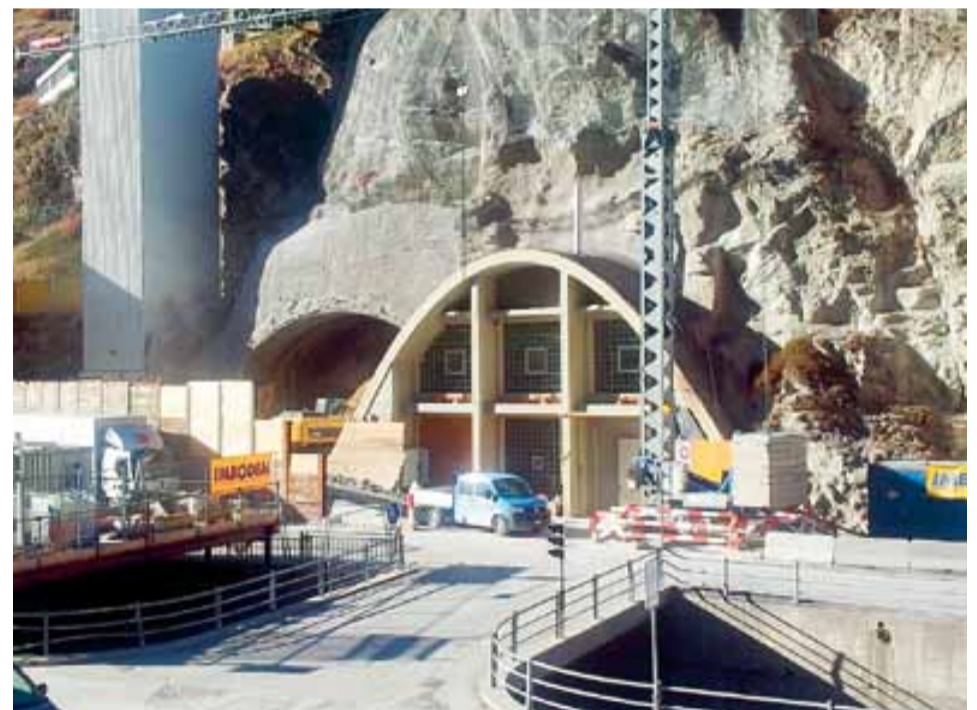
Links: Felsausbruch für Schlammgebäude.
