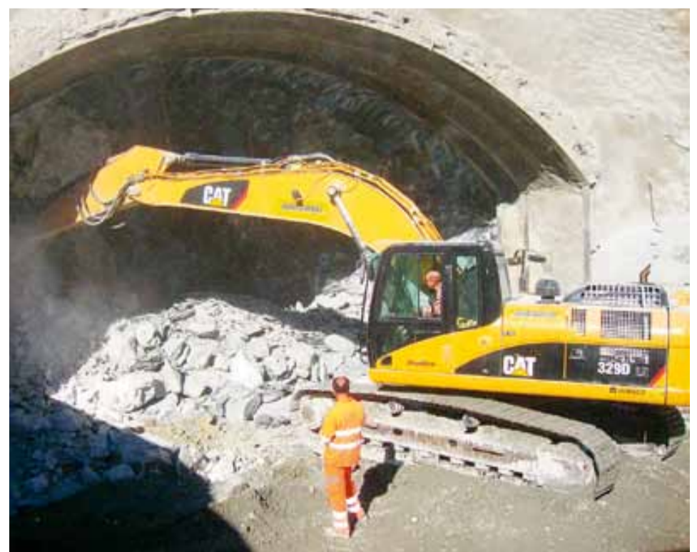
Der Einsatz von grossen Maschinen ist notwendig.
