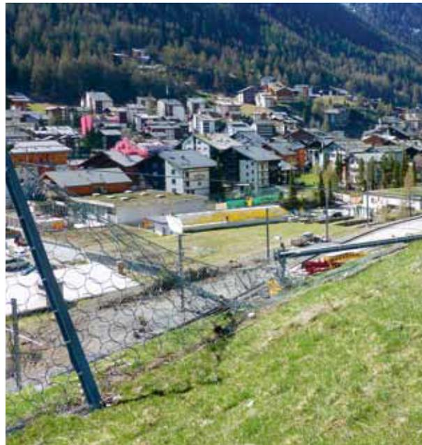
Mitte Mai wurde mit den Räumungsarbeiten entlang des Wanderweges begonnen, die beschädigten Netze demontiert und die Fundamente hergerichtet. Gegen Mitte Juni sollen sämtliche Instandstellungsarbeiten abgeschlossen sein.
