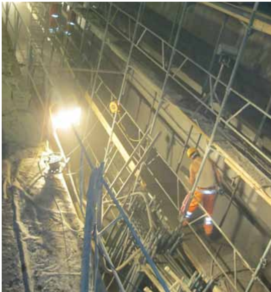
Impressionen von der Baustelle im Berginnern.
