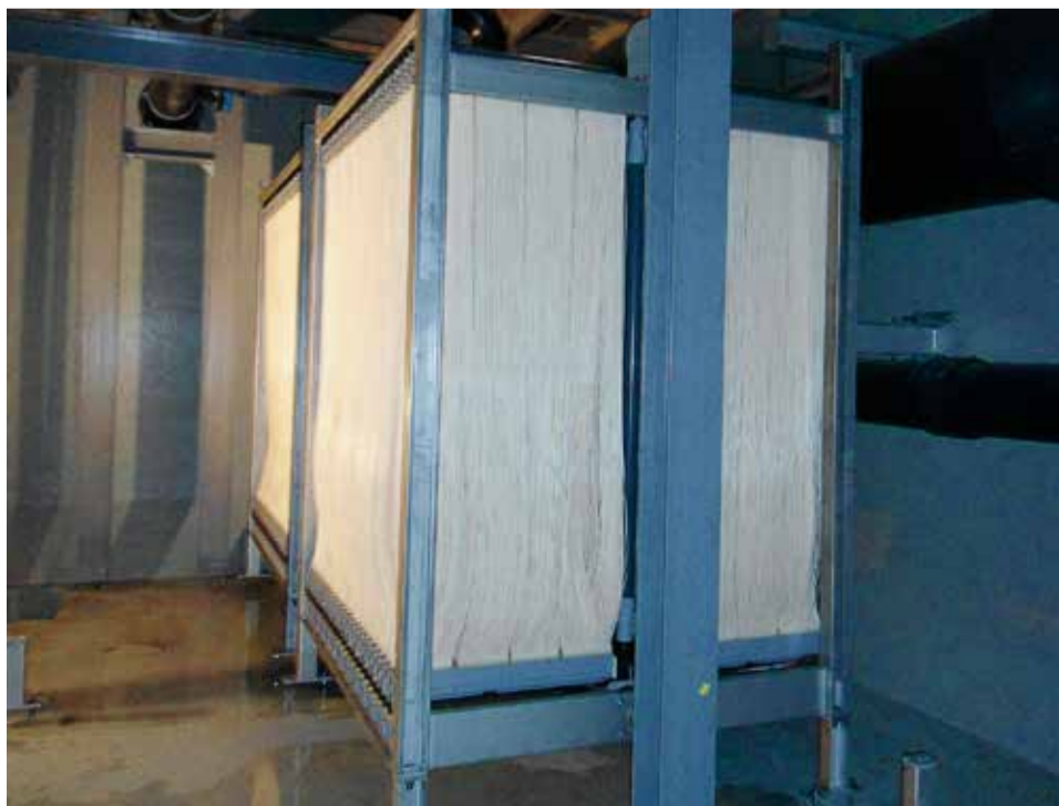
Membrankassetten im Membranfiltrationsbecken installiert.
