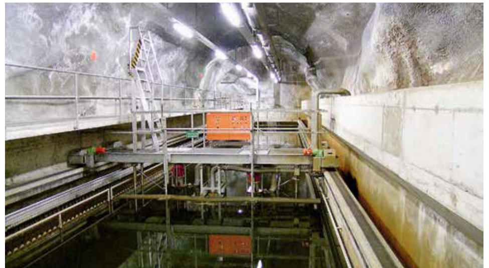
Vor dem Ausbau: Nachklärbecken (offen).
