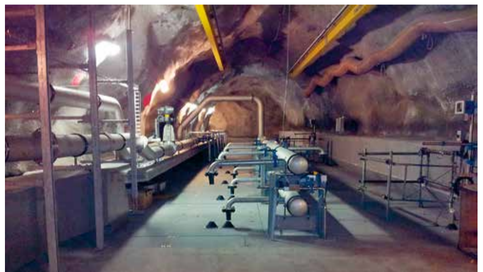
Nach dem Ausbau: Nitrifikations- und Membranfiltrationsbecken (abgedeckt).
