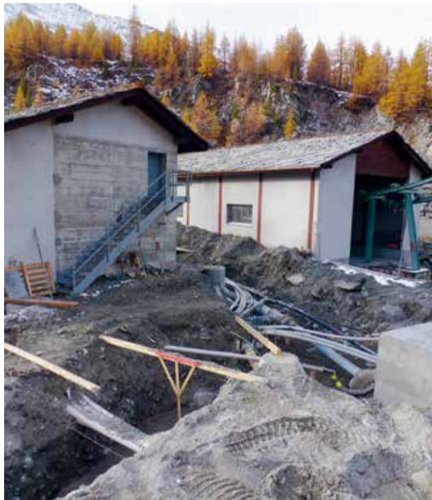
Ausbauarbeiten im Sommer: Da die Beschneigungsanlagen ca. 4 Monate im Einsatz sind, kann es zu Standschäden kommen.
