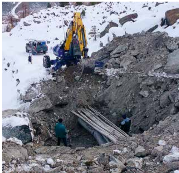
Rohrbruch im Gebiet Gant-Breitboden.
