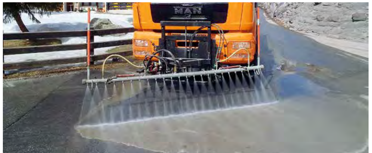
Die Lösung tränkt den Boden und hält ihn ausreichend feucht. So wird der Staub gebunden und der Boden ist vor dem Austrocknen geschützt.
