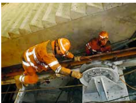
Die letzten Anpassungen der Gleisbauer in der Bergstation.
