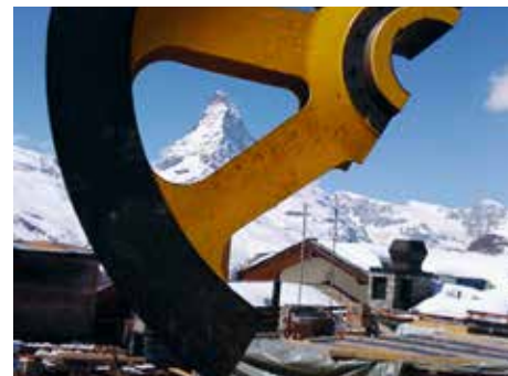
Abtransport des Mittelteils der hinteren Umlenkung mit seitlichem Antrieb (Gewicht: 11 Tonnen).
