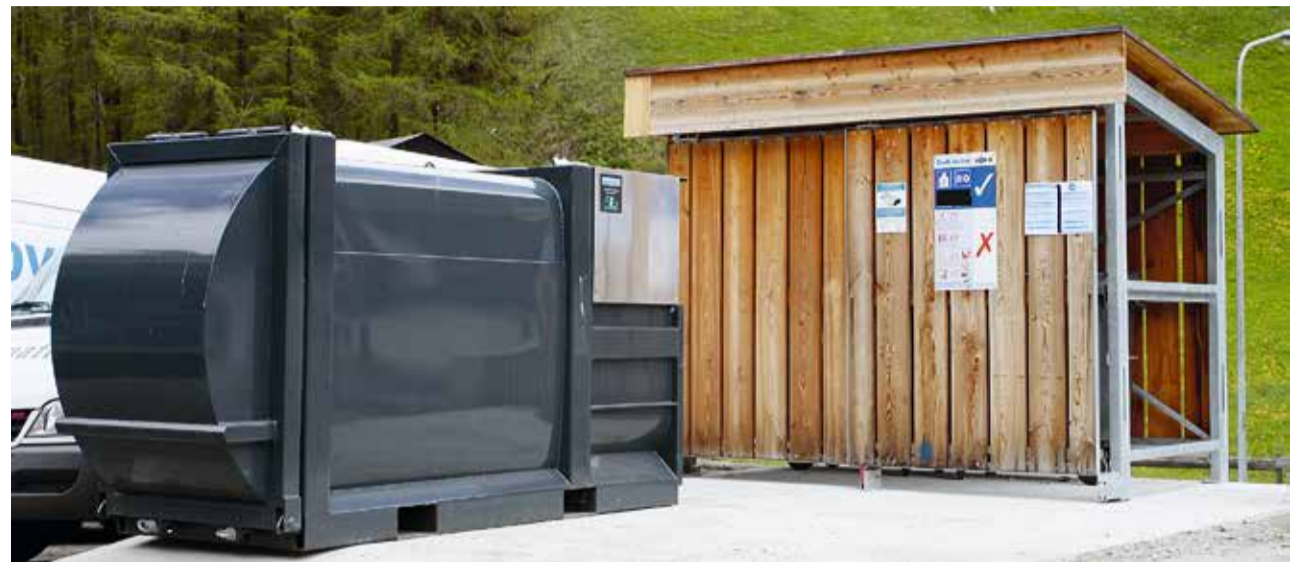
Der neue Alpenluft-Presscontainer bei den umgebauten Kehrichtunterständen.
