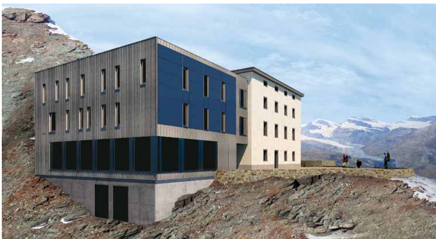
Die neue Hörnlihütte mit Anbau und Fotovoltaikanlage in der Fassade.
