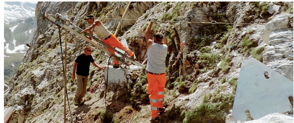
Installation der Bohreinrichtung für das neue Steinschlagnetz.
