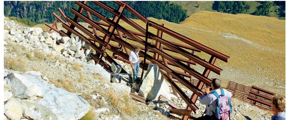
Bei einem Steinschlag im Herbst 2011 wurden die Lawinenverbauungen Schweifinen arg in Mitleidenschaft gezogen.
