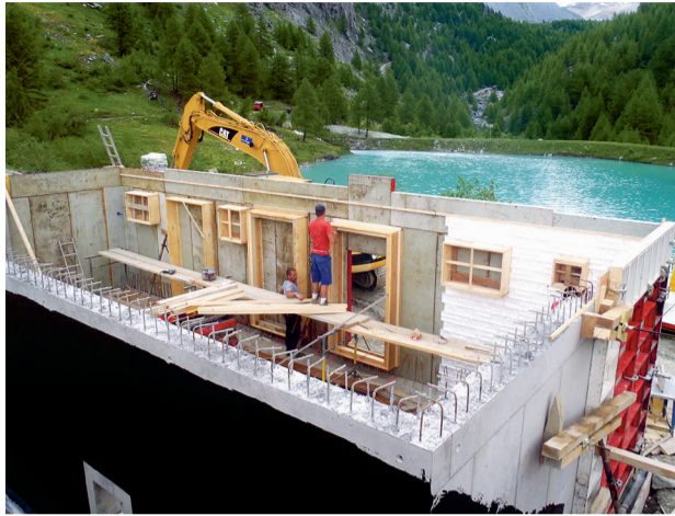
Die neue Pumpstation am Moosjisee.
