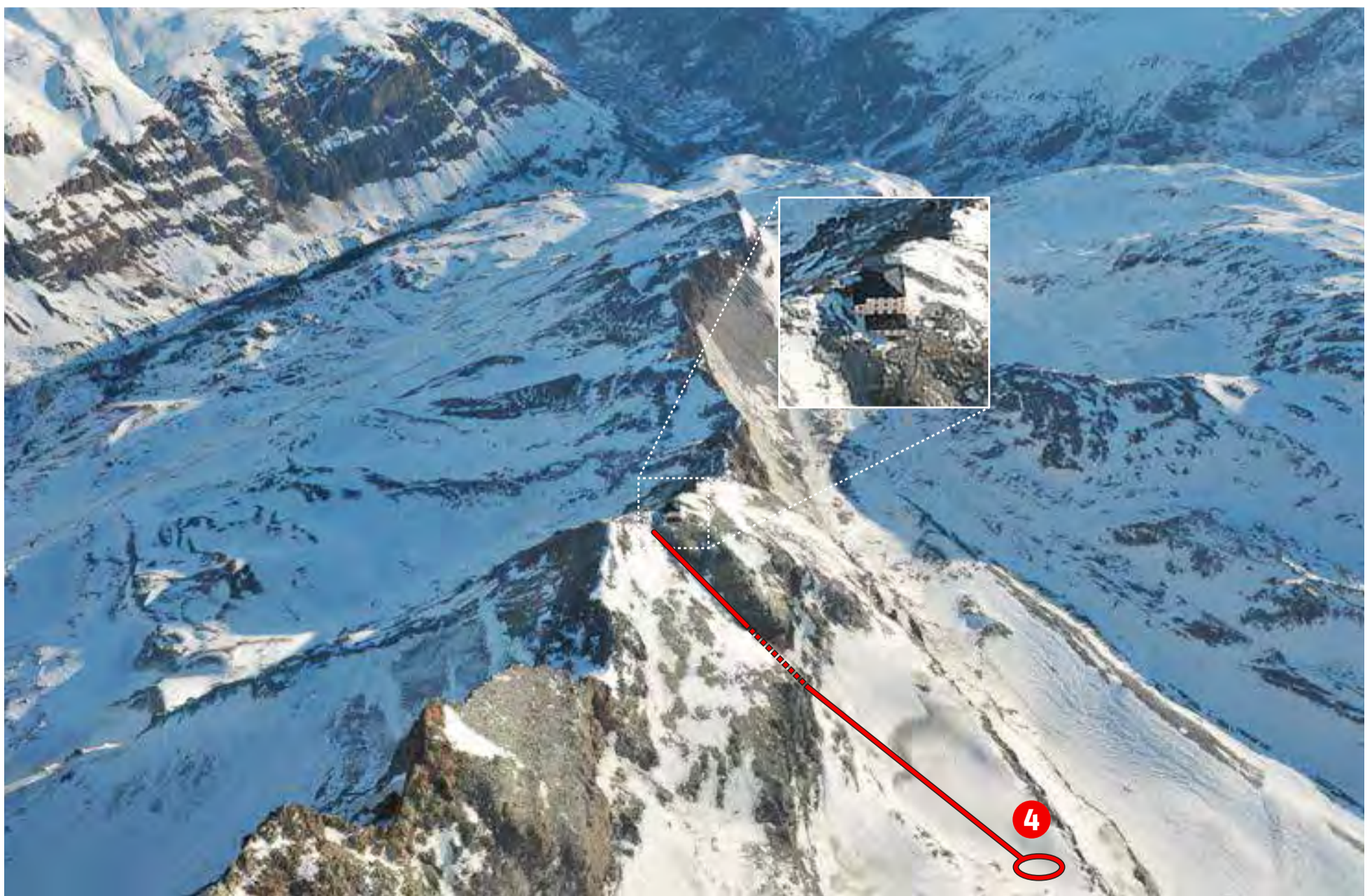
Hörnlihütte 2015 – Wasserversorgung. 4 Neue Fassung und Zuleitung von Süden
