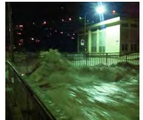
Bei der Wiestibrücke brandete das Wasser erstmals seit deren Erbauung über die Brückenkronen.
