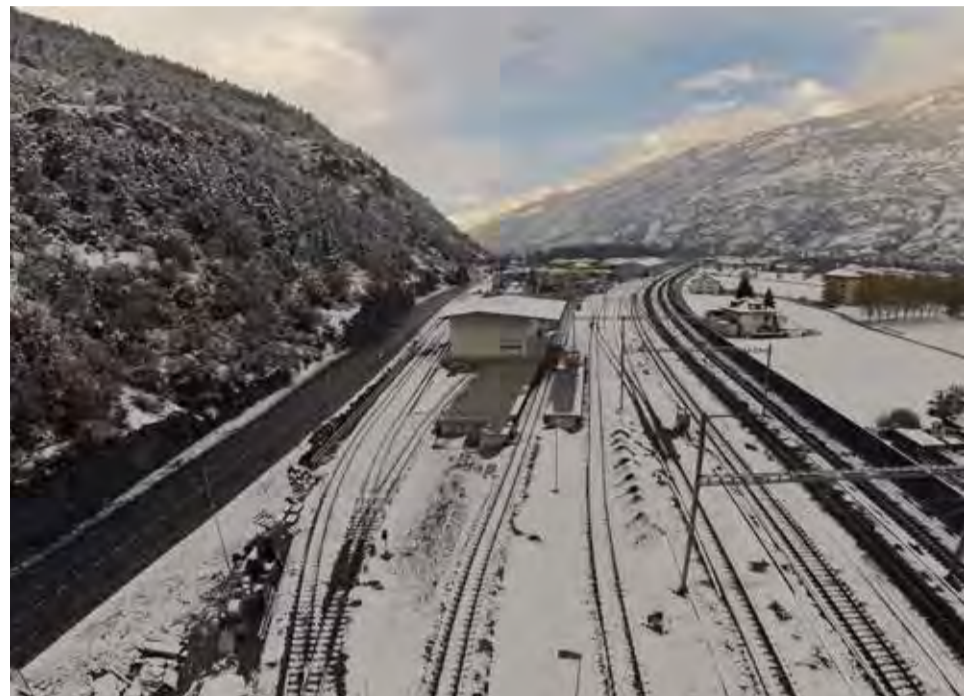
Der neue Güterterminal Bockbart.
