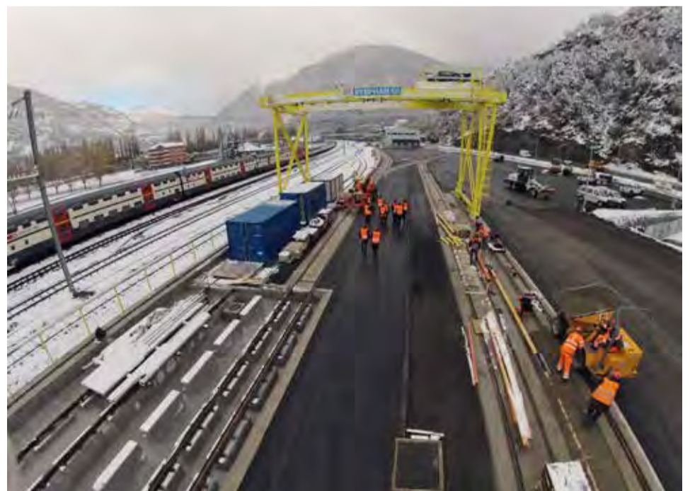
Der 30-Tonnen-Portalkran für den Umlad zwischen SBB, MGBahn und LKWs.
