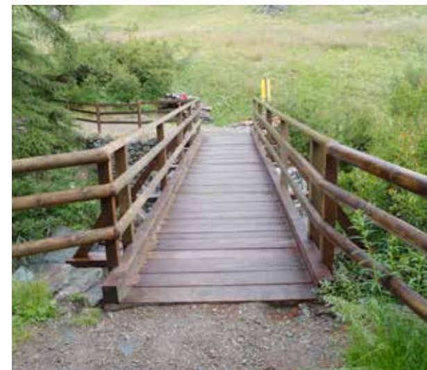
... und erstrahlt nach der Beendigung der Arbeiten in einem neuen Glanz.
