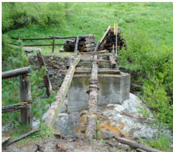
Die alte Brücke in Findeln (Weg der Stille) musste abgerissen werden ...
