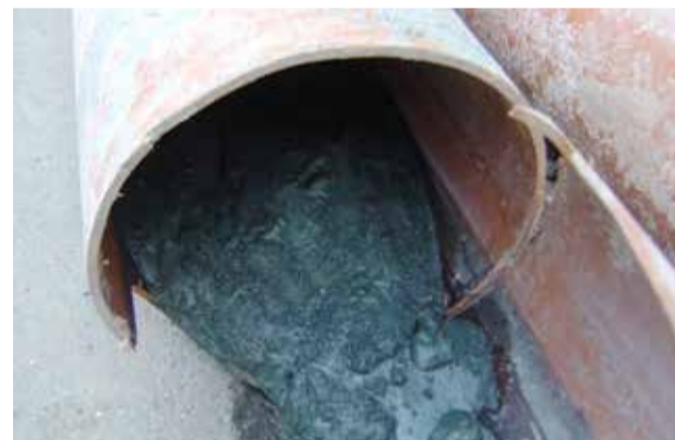
Rückstände in einer Leitung.
