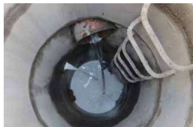
Verbotene Einleitung von Farbe.
