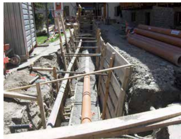
Eine Hauptleitung wird verlegt.
