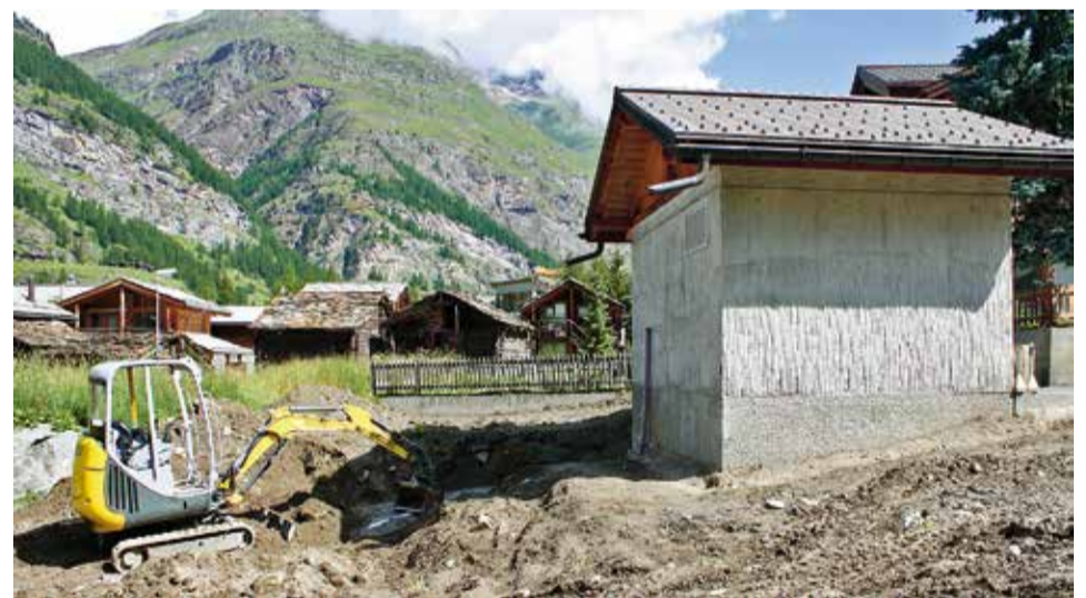
Die Bauarbeiten am neuen öffentlichen Kehrreueunterstand an der Moosstrasse.
