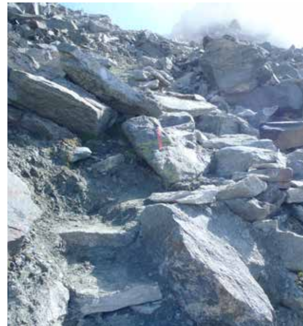
Die Passage Pfulwe wurde von Mitarbeitenden des Technischen Dienstes während mehreren Tagen aufwendig saniert.
