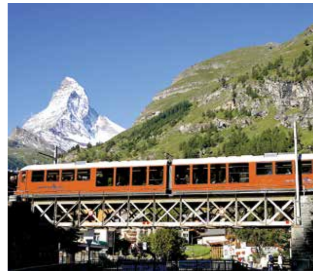
Die alte Getwingbrücke muss ersetzt werden.
