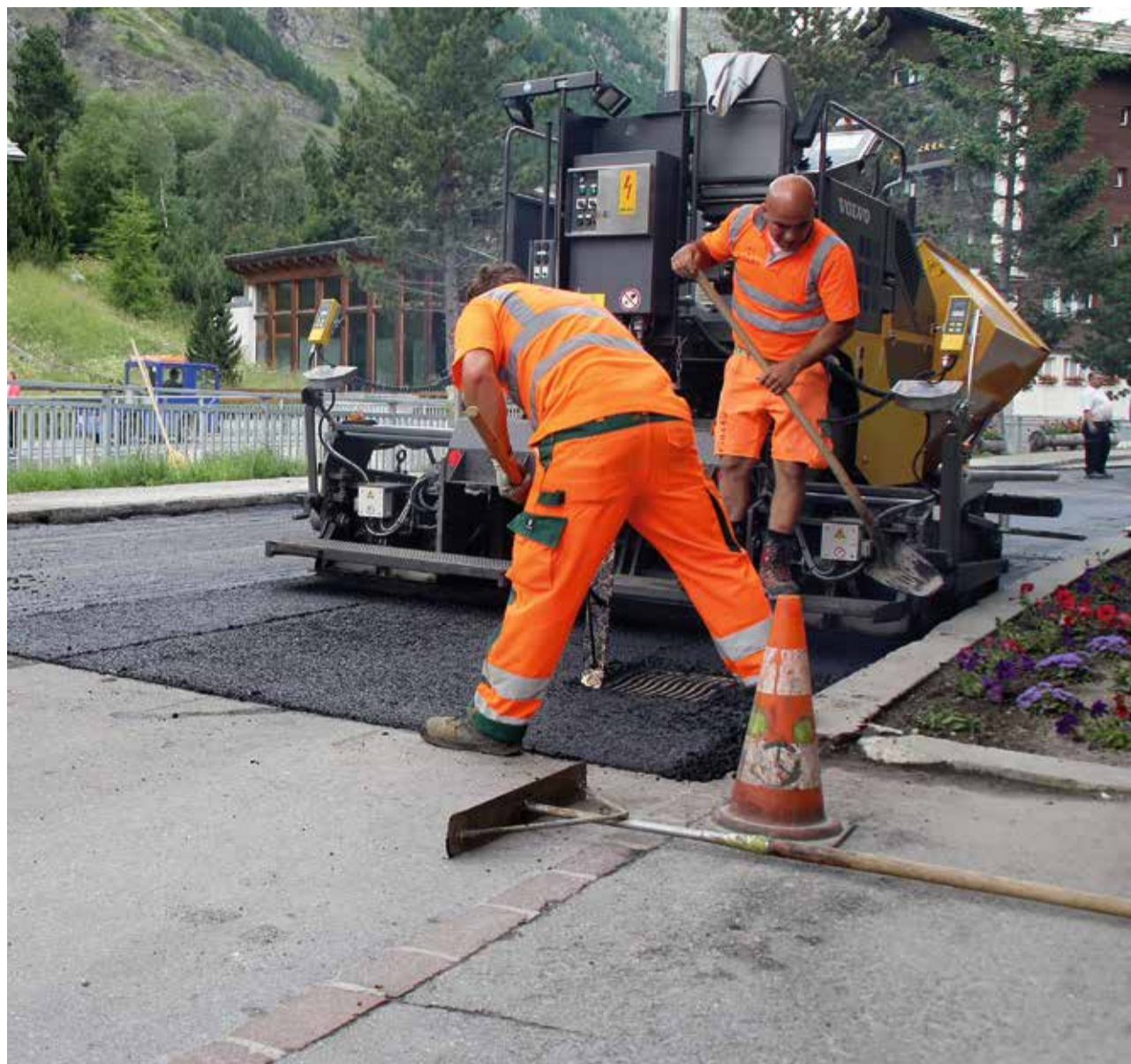
Im September sind an verschiedenen Orten Belagsarbeiten vorgesehen.
