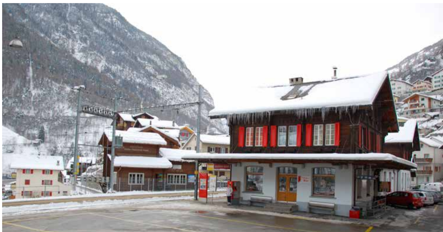
Auf der Strecke zwischen Visp und Zermatt kommt es im Oktober und November zu Unterbrüchen im Bahnverkehr – neben verschiedenen Bauarbeiten entlang der Strecke kommt es auch zu einem Umbau des Bahnhofs in Stalden.
