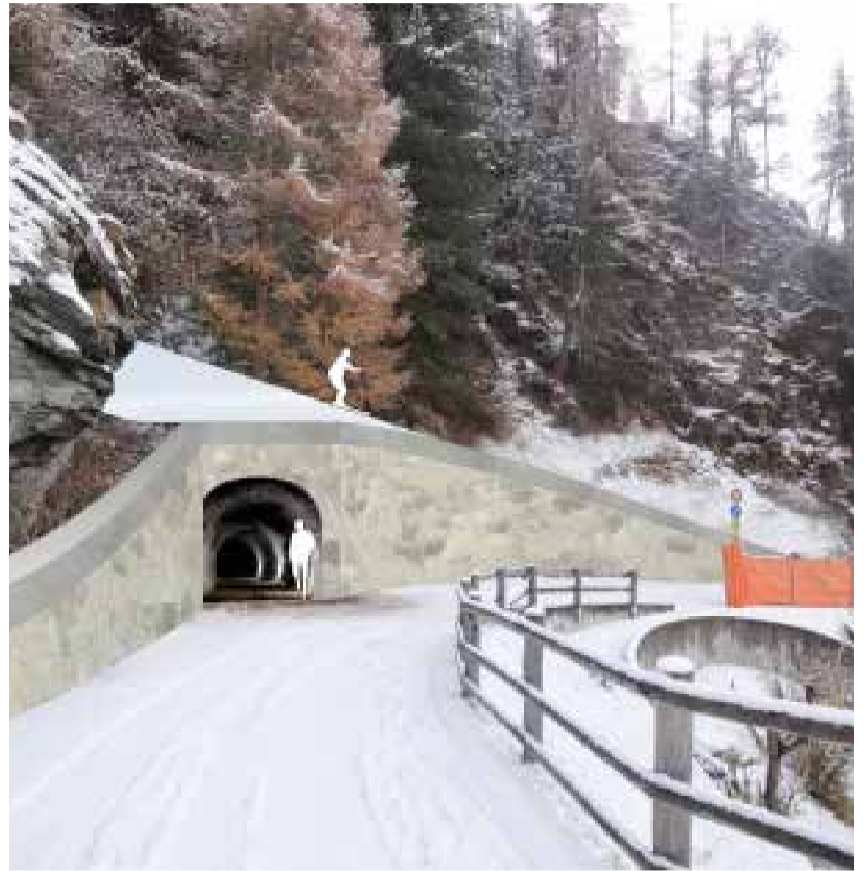
Blick Richtung Fussgängertunnel und Pistenende «Howette» im Gebiet «Gibje».
