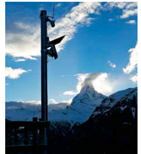
Radaranlage: Lawinenwarnanlage Ried
