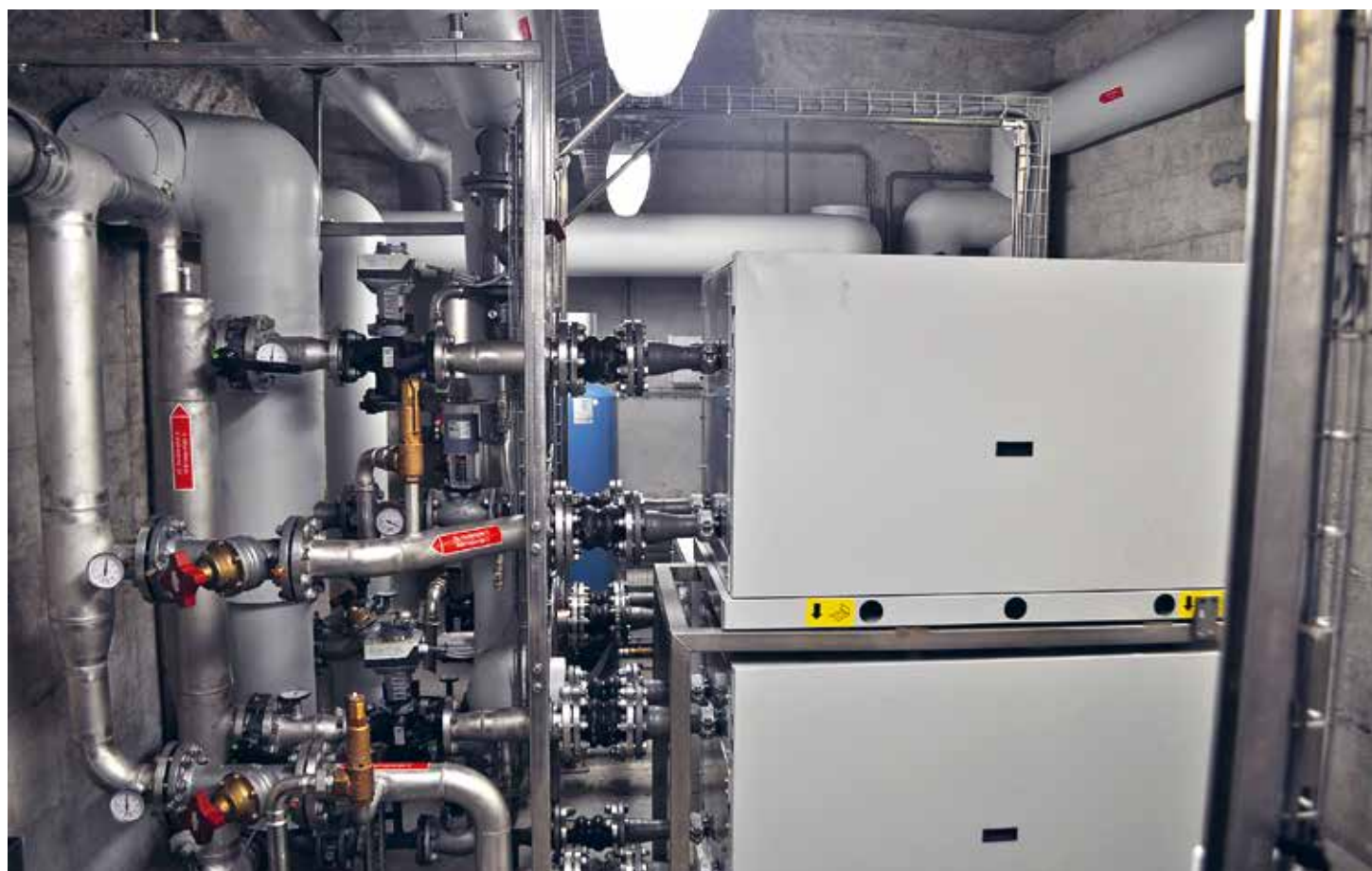
Wärmepumpen und Heizleitungen
