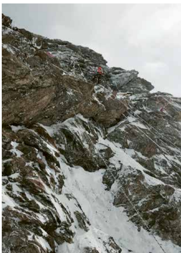
Felssicherungsarbeiten auf Matterhorn glacier paradise.
