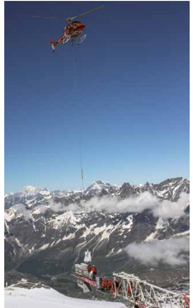
Kranmontage: Air Zermatt packte mit an. Um den Kran zu errichten, mussten die Teile per Helikopter transportiert werden.
