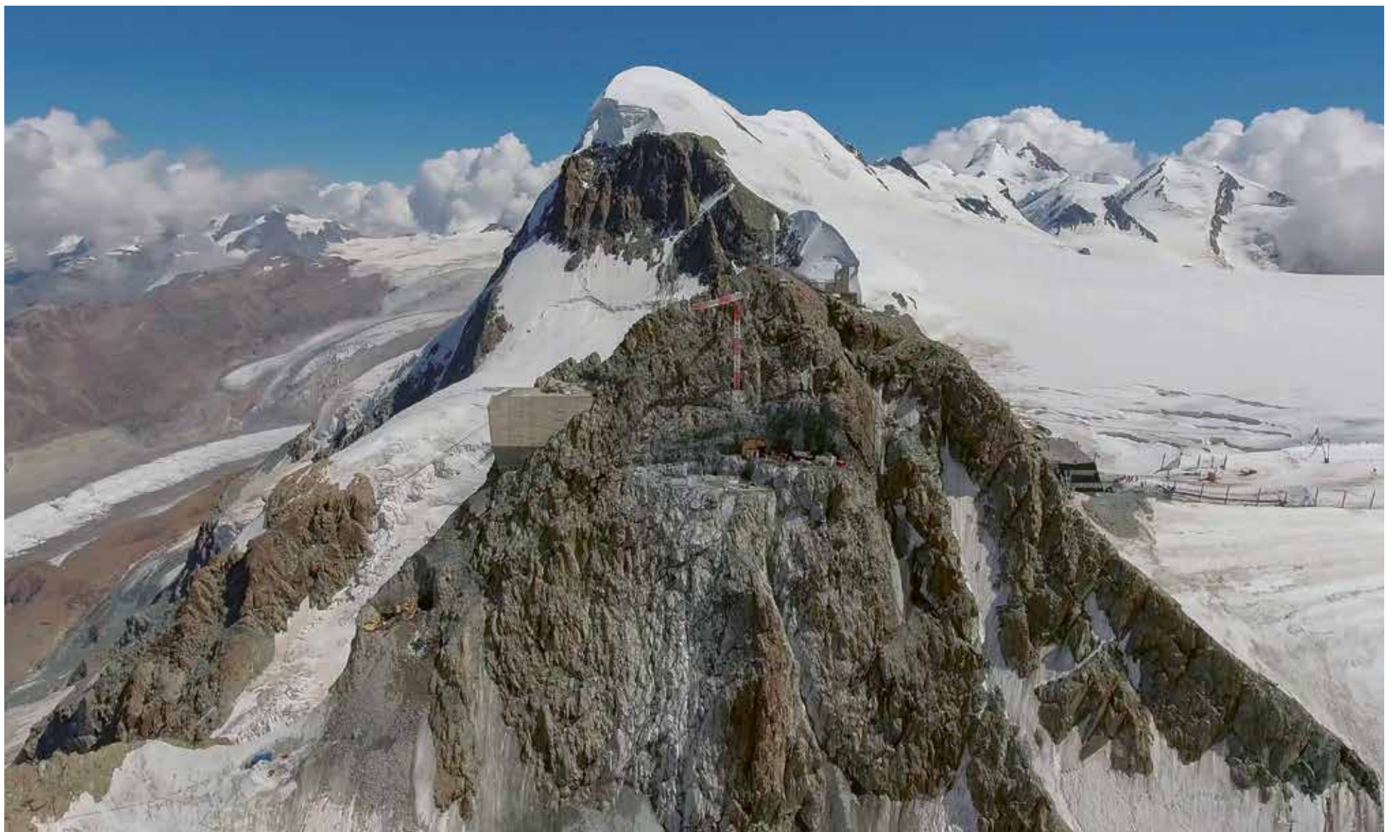
Bergstation: Imposante Baustelle. Hier wird die Bergstation der 3S Bahn errichtet.
