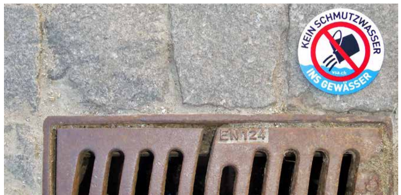
Einlaufschächte, welche direkt in ein Gewässer eingeleitet werden.
