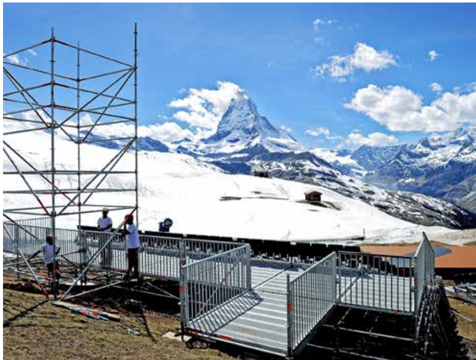
Die Bühne wurde in den letzten Tagen aufgebaut. Der Schnee schmilzt bestimmt bis zur Premiere von Anfang Juli.
