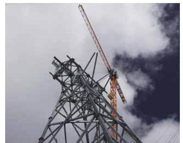
Für die Montage der dritten 40 Meter hohen Stahlstütze musste ein zusätzlicher 52 Meter hoher Kran eingesetzt werden.
