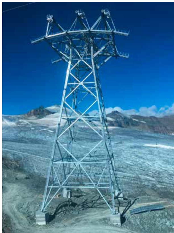
Anfang Juni 2017 wurde mit der Montage der zweiten Stütze begonnen.
