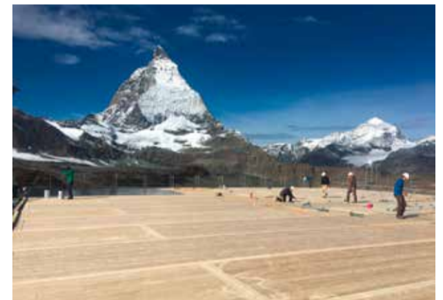
Die erste Lage der Dachabdichtungen der Talstation ist verlegt.
