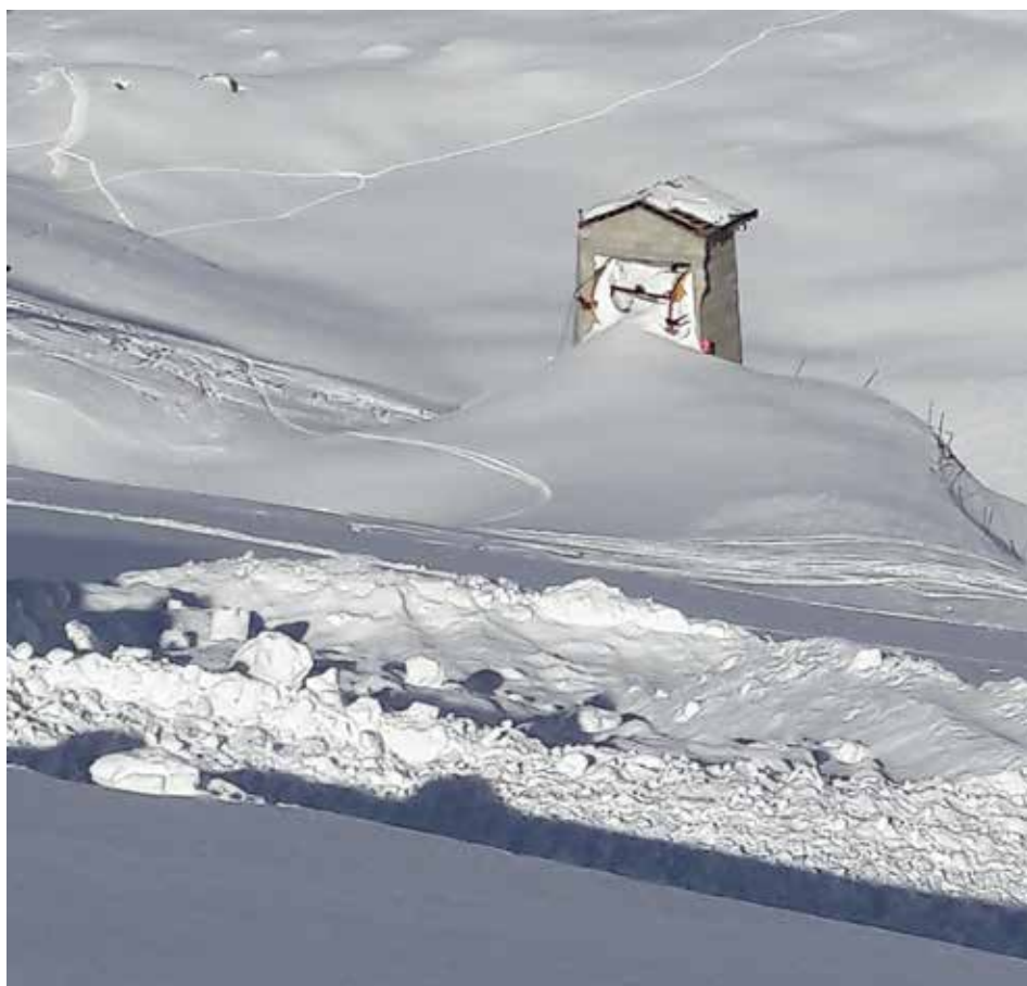
Eine Lawine hat im Januar die aus Beton erbaute Talstation des Sessellifts fast gänzlich zerstört.
