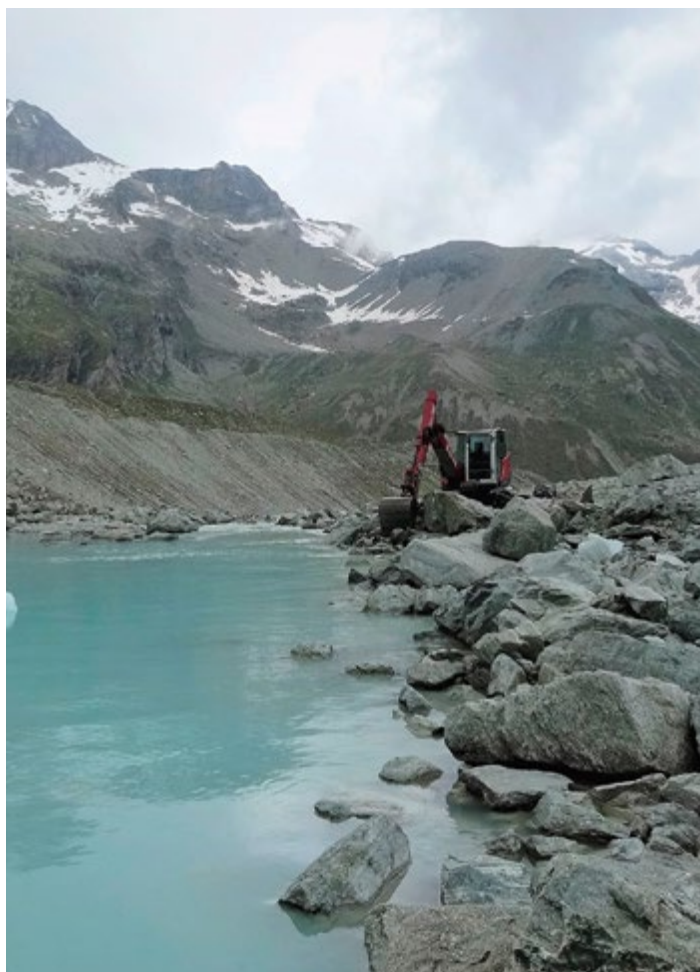
Baggerarbeiten beim oberen Triftsee.
