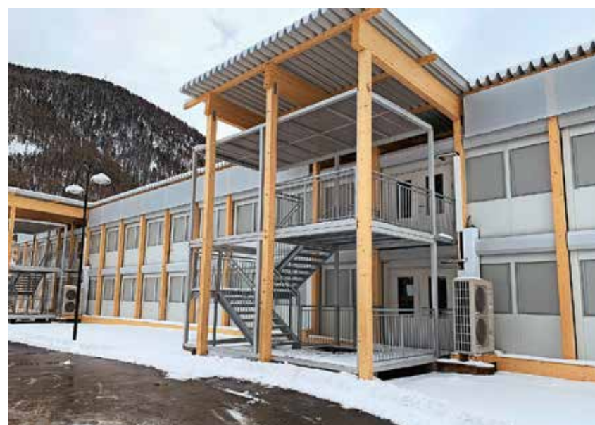
Schulhausprovisorium Obere Matten
