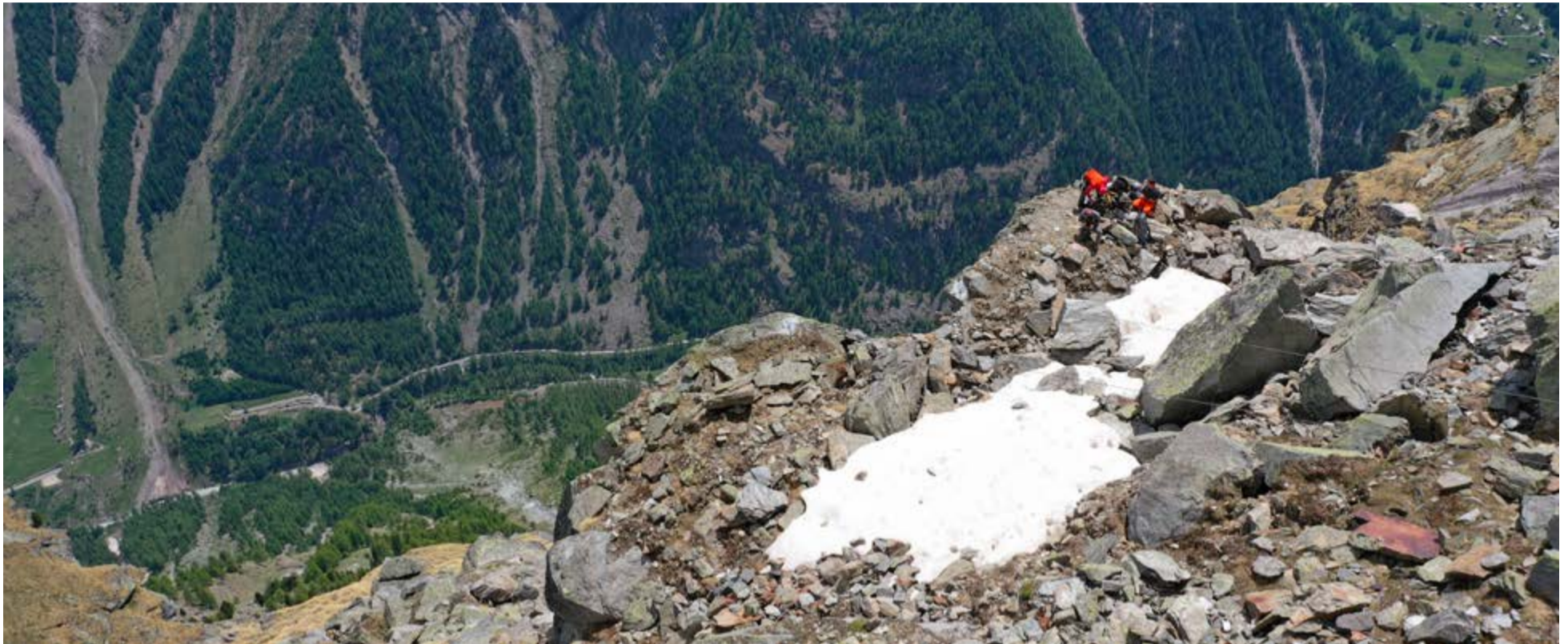
Vorbereitung der Sicherheitssprengung im Gebiet «Kalter Boden»
