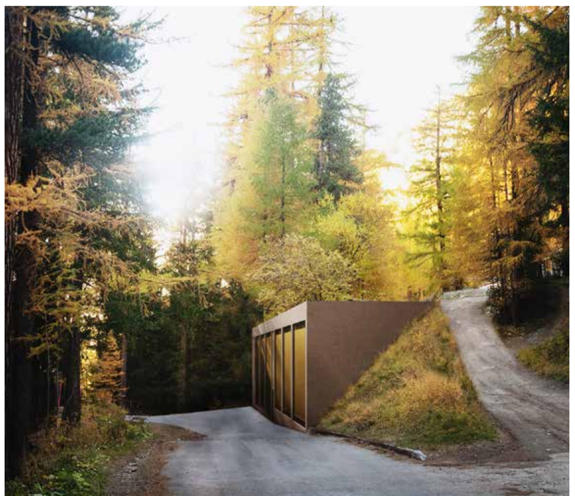
Neues Unterwerk Moos
