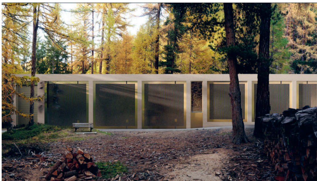
Neues Unterwerk Moos
