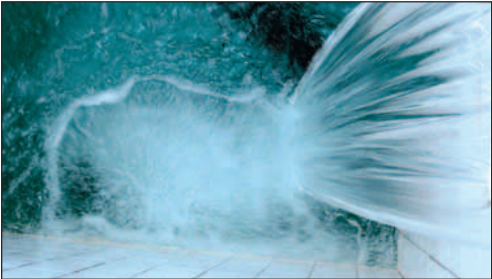
Einblick in eine der Anlagen der Wasserversorgung Zermatt (WVZ).
