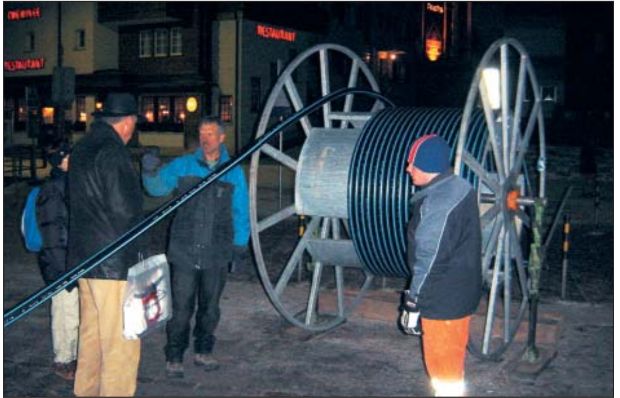
Aufgrund der massiven Wasserknappheit musste notfallmässig eine provisorische Wasserversorgung von Zermatt zum Restaurant Sunnegga hergestellt werden. Über Nacht stellte die Luzerner Firma Mauderli den nötigen Spezialhochdruckschlauch her, der mit Hilfe vieler freiwilliger Helfer eingezogen wurde.
