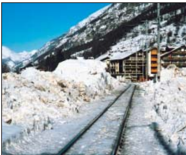
Am 4. Februar 2003 verschüttete ein Lawinnenniedergang das Bahntrasse bei Täsch.
