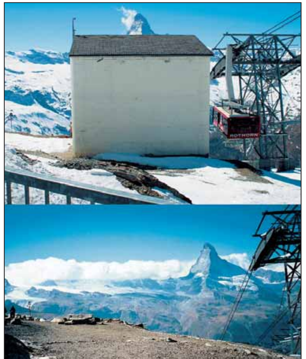
Freie Sicht aufs Matterhorn: Die «alte» Station Rothorn vor (oben) und nach dem Abbruch.
