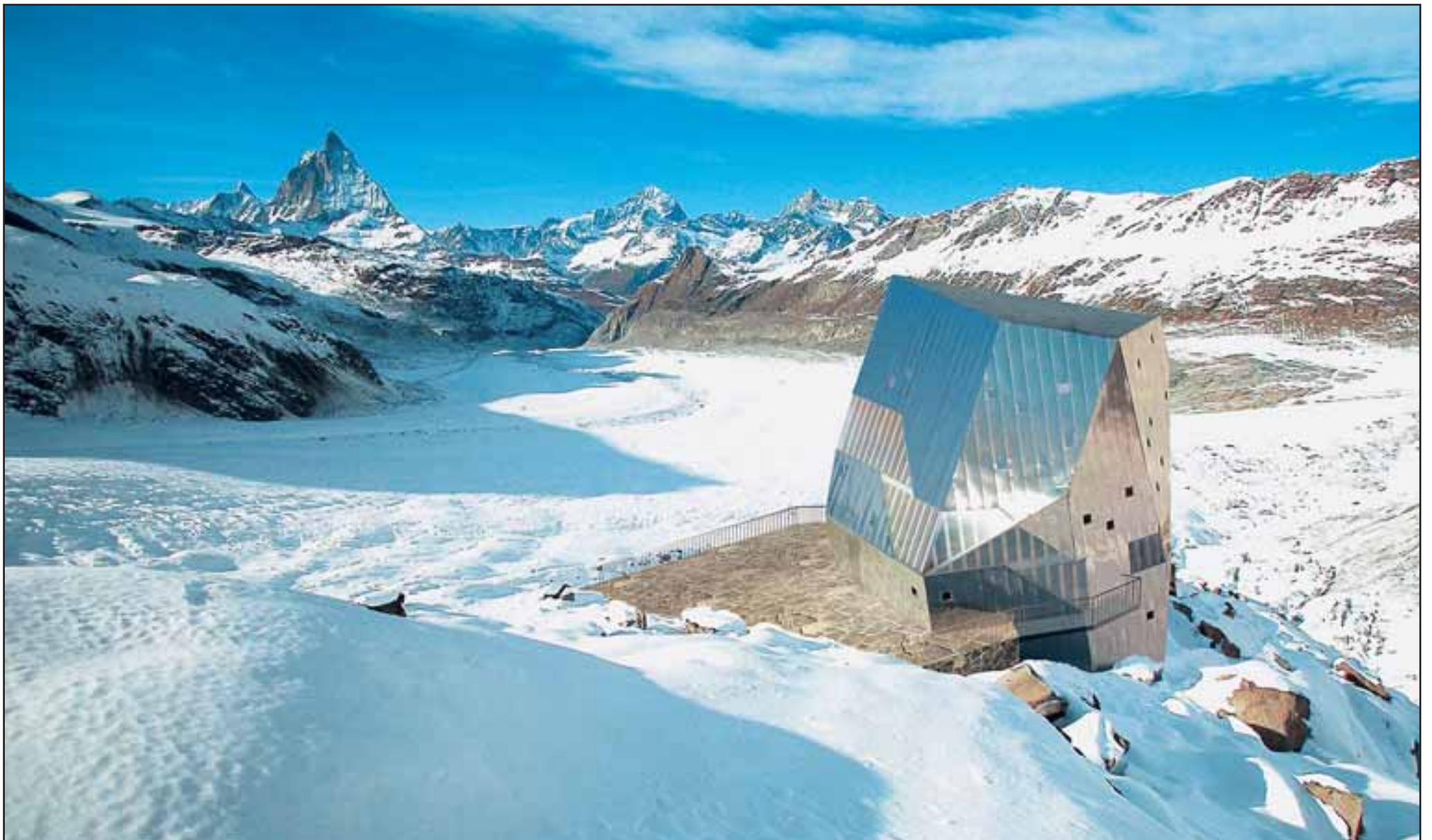
Eine geschickte Kombination von Lowtech, Hightech und clever konzipierter Architektur: Die ETH Zürich und der SAC realisieren bis Sommer 2006 die Neue Monte Rosa Hütte.
