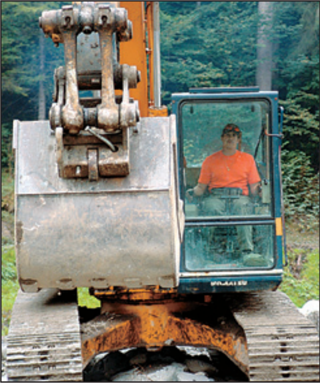
Die bis zu 30 Tonnen schweren Bagger wurden gratis von Privatunternehmungen zur Verfügung gestellt.
