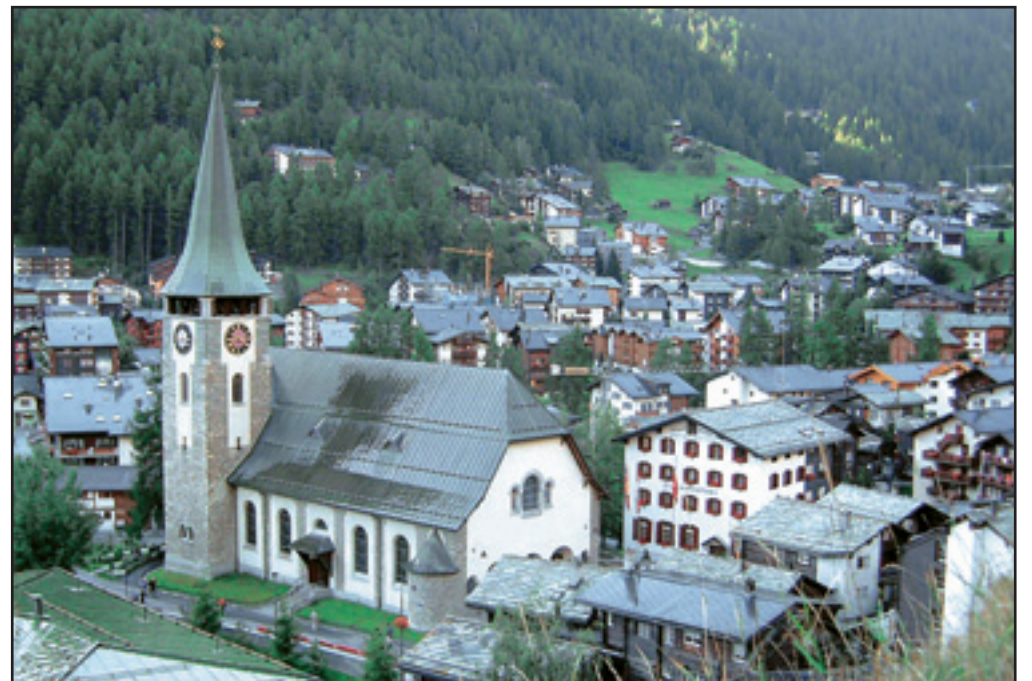
Das Bauwesen und der Verkehr bildeten im vergangenen Jahr die dominierenden Themen, mit denen sich der Gemeinderat von Zermatt auseinander setzen musste.
