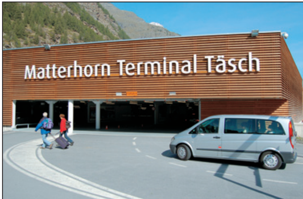
Im Matterhorn Terminal Täsch wird am 18. Dezember 2006 der Gesamtbetrieb aufgenommen.
