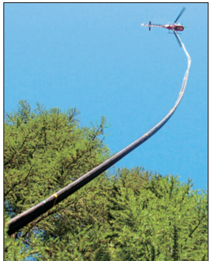
Spektakulärer Helikoptereinsatz: Die bis zu 100 Meter langen Doppelrohrkombinationen wurden als Unterlast eingeflogen.
