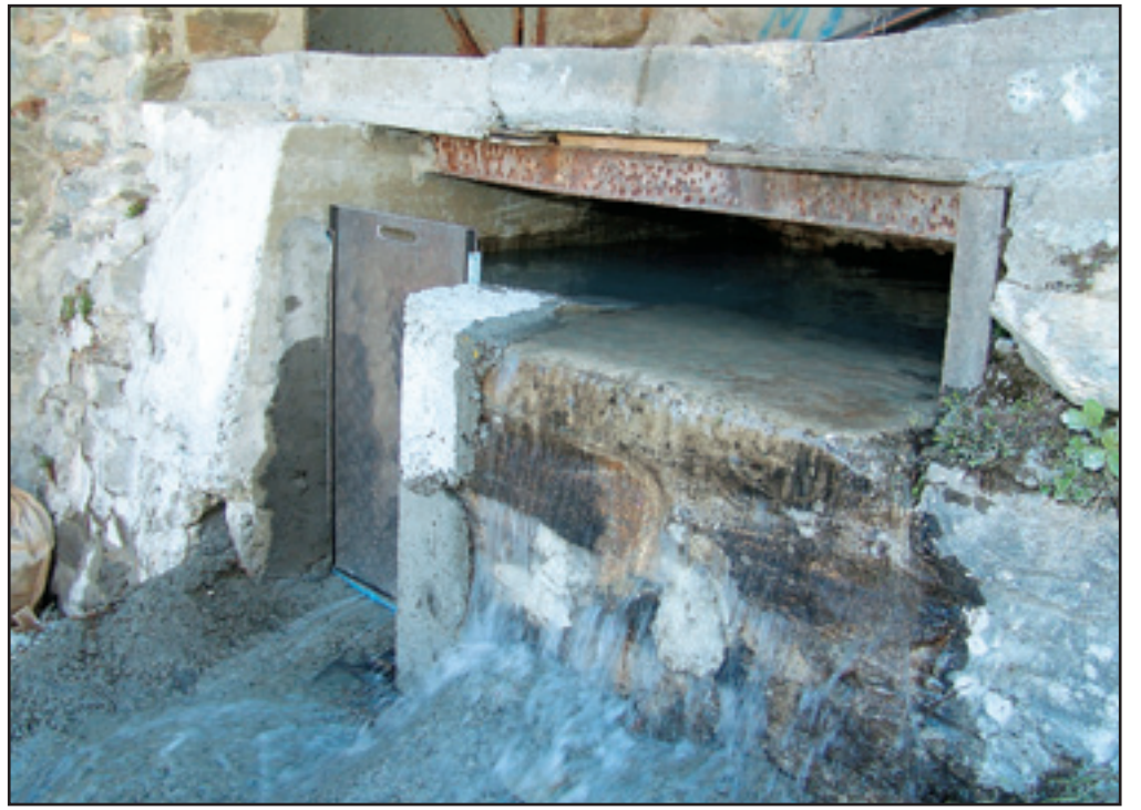
Vor dem Wassereintritt in die Rohrleitung entstanden eine Schleuse und ein kleiner Entsander.
