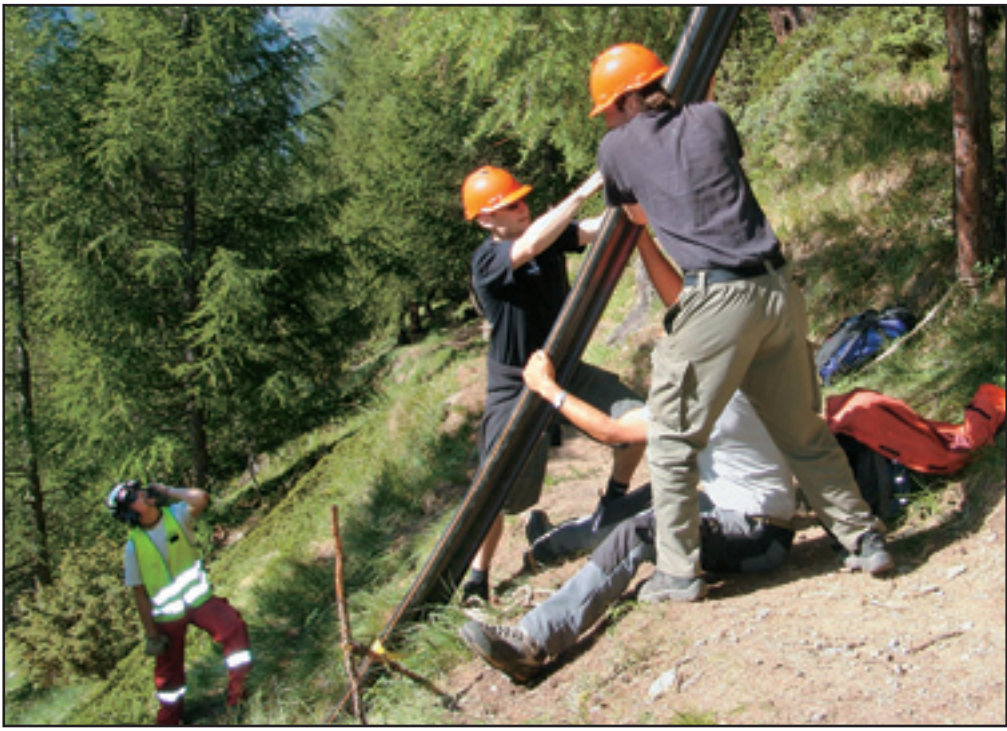
Piloten, Flughelfer, Mitglieder der ZSO sowie Mitarbeiter der EWZ arbeiten gemeinsam an der Bewässerungszuleitung.
