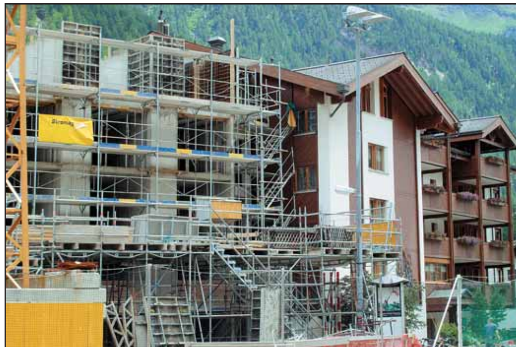
Der Erweiterungsbau des Alters- und Pflegeheims St. Mauritius kommt gut voran.
